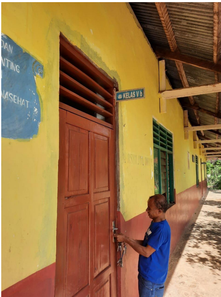
Gambar 4.1 Kondisi SD Masehi
